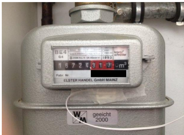
Abbildung 4: Gaszähler mit Reed-Kontakt
