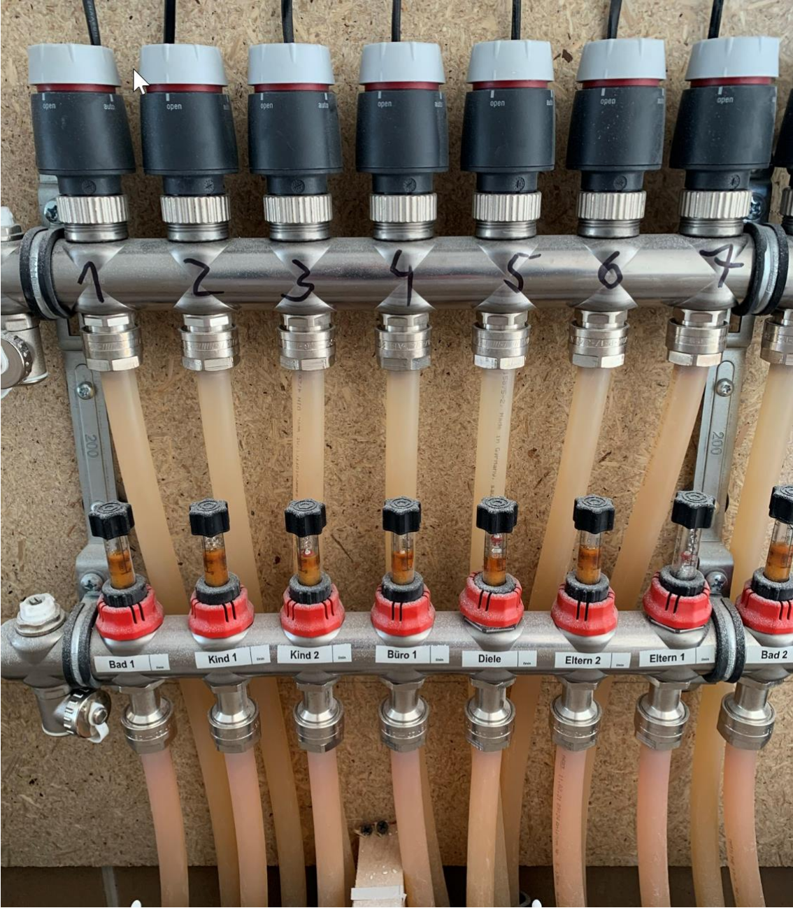
Heizungsverteiler:
